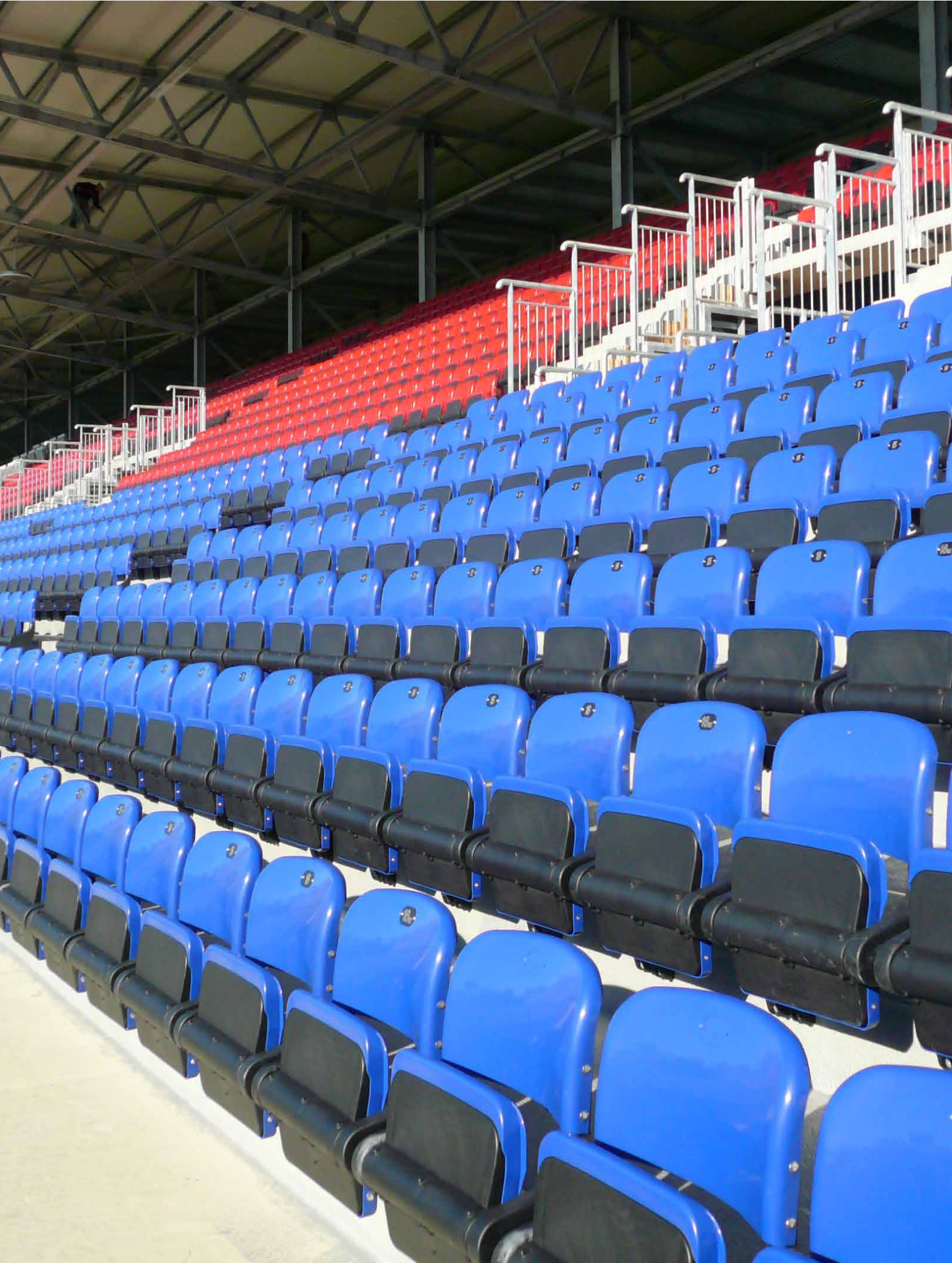
STADIO "IS ARENAS" - QUARTU S. ELENA - CAGLIARI, ITALIA
