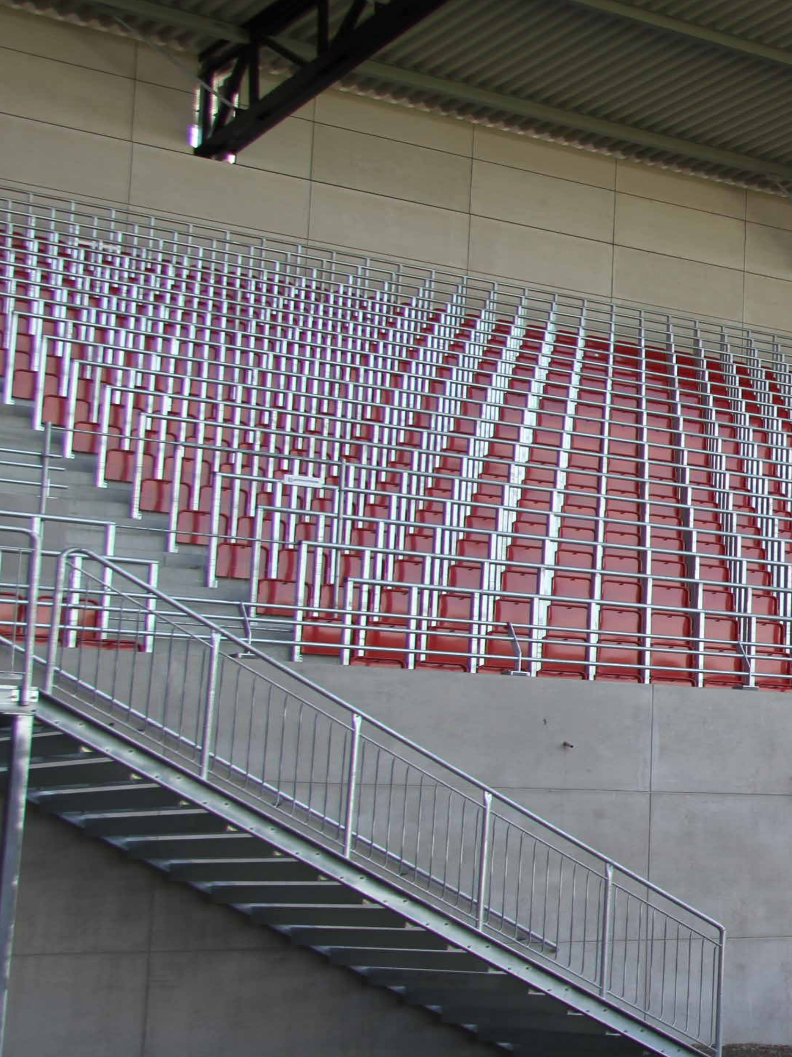
OLYMPIA FOOTBALL STADIUM - HELSINGBORG, SUÈDE
