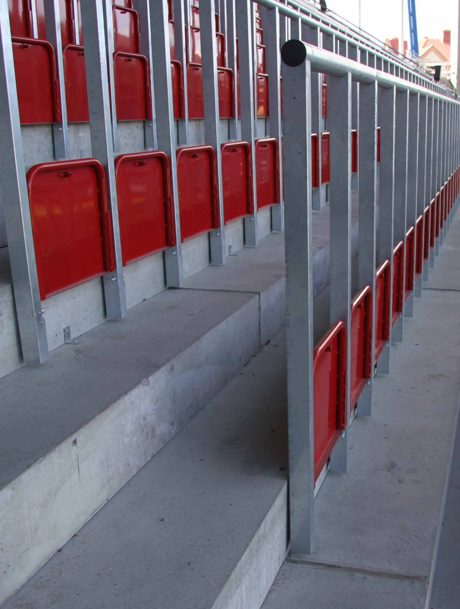
OLYMPIA FOOTBALL STADIUM - HELSINGBORG, SUÈDE
