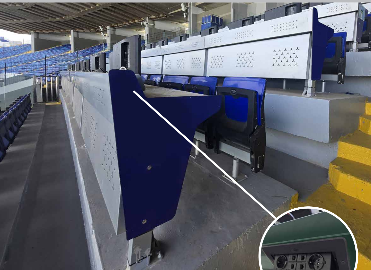
Predisposizione prese elettriche in vano a scomparsa / Hidden slot pre arranged for electrical socket
